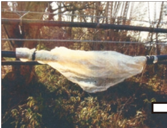
ビニールによる仮修理
